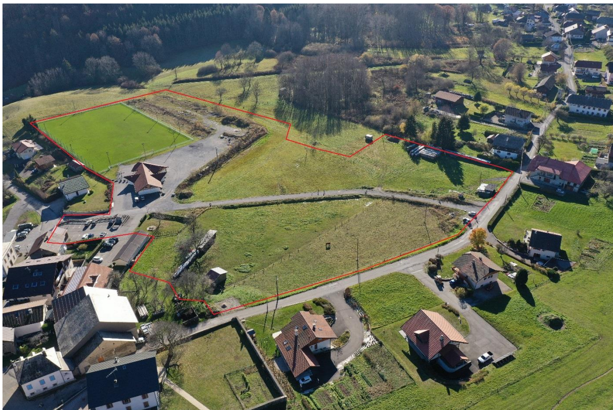
Vu sur l'ensemble de la zone d'étude (en rouge limite approximative OAP en projet) (Epode, novembre 2020)
