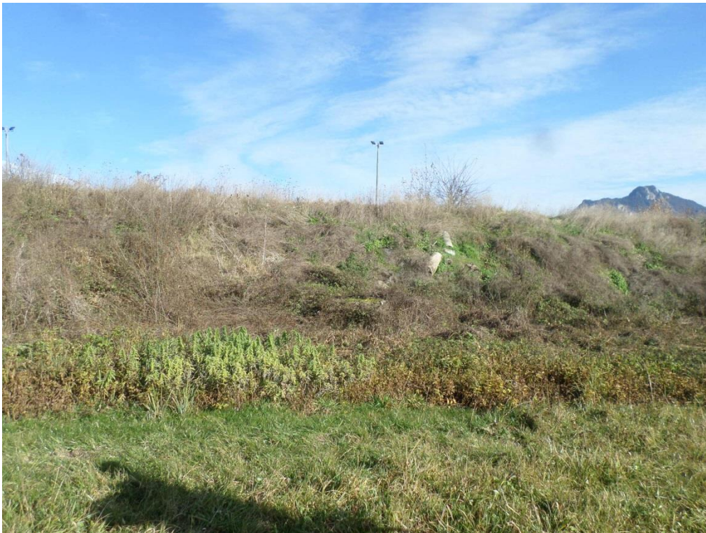
Mur de remblai (Epode, novembre 2020)
